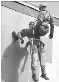
Példa: Evakuálás a Milan leeresztőeszközzel.
